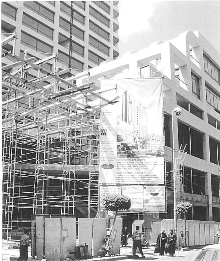
Photographie 63 : Projet immobilier, Taj Tower, rue Hamra (Cliché : Boudisseau, 2001)
