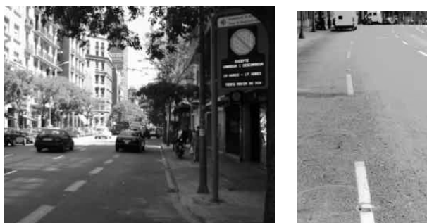
Photo 12 : Voie délimitée par une peinture de couleur rouge ou par des balises lumineuses
