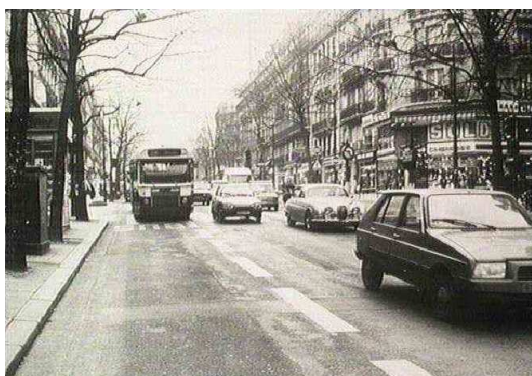
Photo 4 : Couloir de bus matérialisé à Paris en 1964
