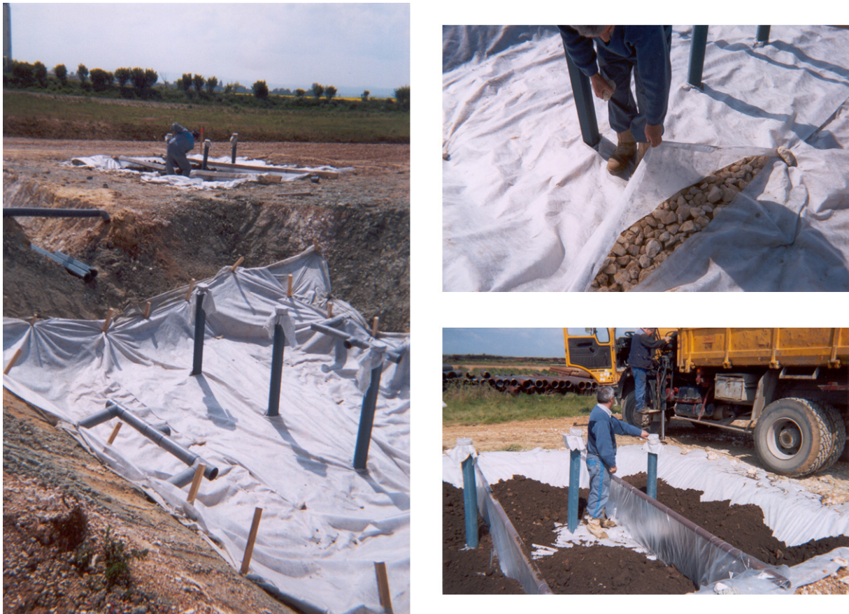
Figure II.3. Mise en dépôt du sol pollué dans les casiers du site pilote.
