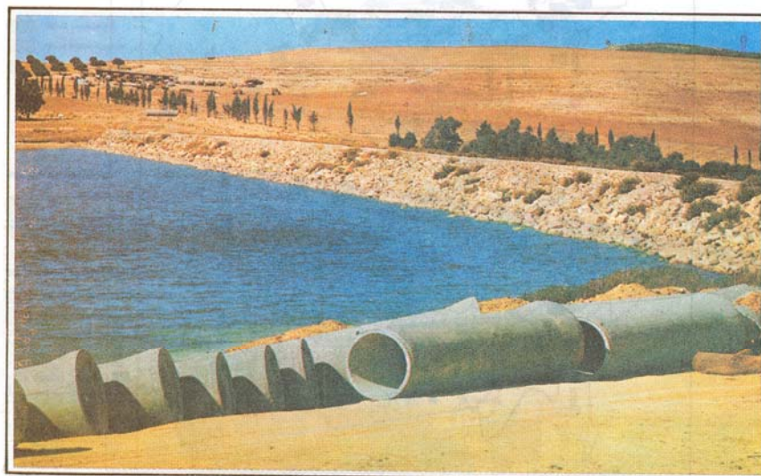
1. Barrage-réservoir de Ghdir-El GOULLA qui alimente la région de Tunis en eau potable
