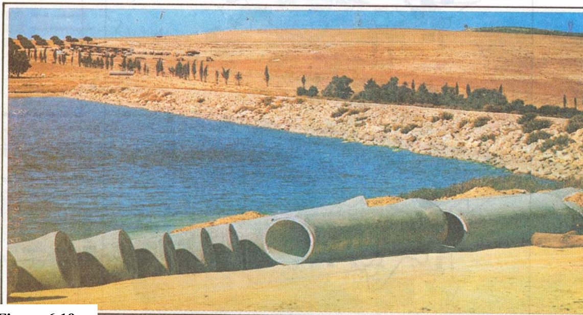
Figure 6.19 Barrage-réservoir de Ghdir-El GOULLA qui alimente la région de Tunis en eau potable
