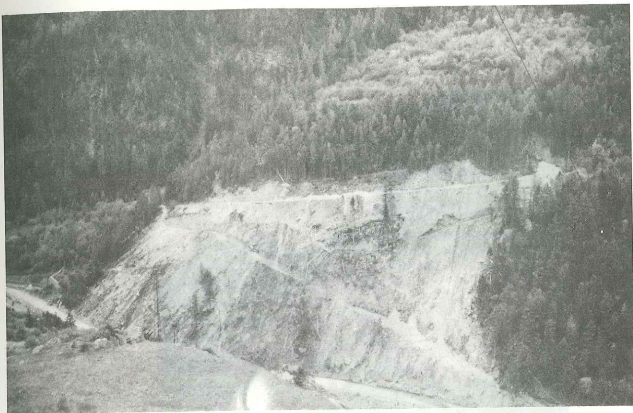
Photo 11 - Vue générale du glissement du Fréney .
