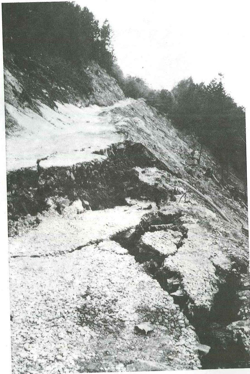
Photo 13 - Détail de la rupture sur la piste B .
