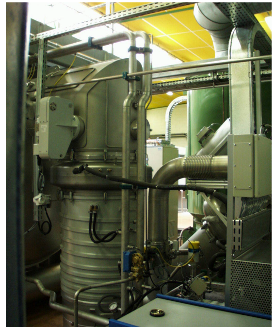
Figure II.2. : Photographies du système de pompage primaire (une pompe à palette et trois pompes Roots) ainsi que du système de pompage secondaire (pompe à diffusion DIF 630)
