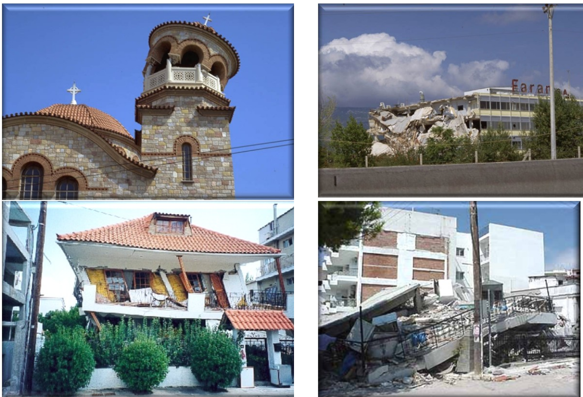
Figure 1. 12 : Aperçu des dommages dus au séisme d'Athènes
