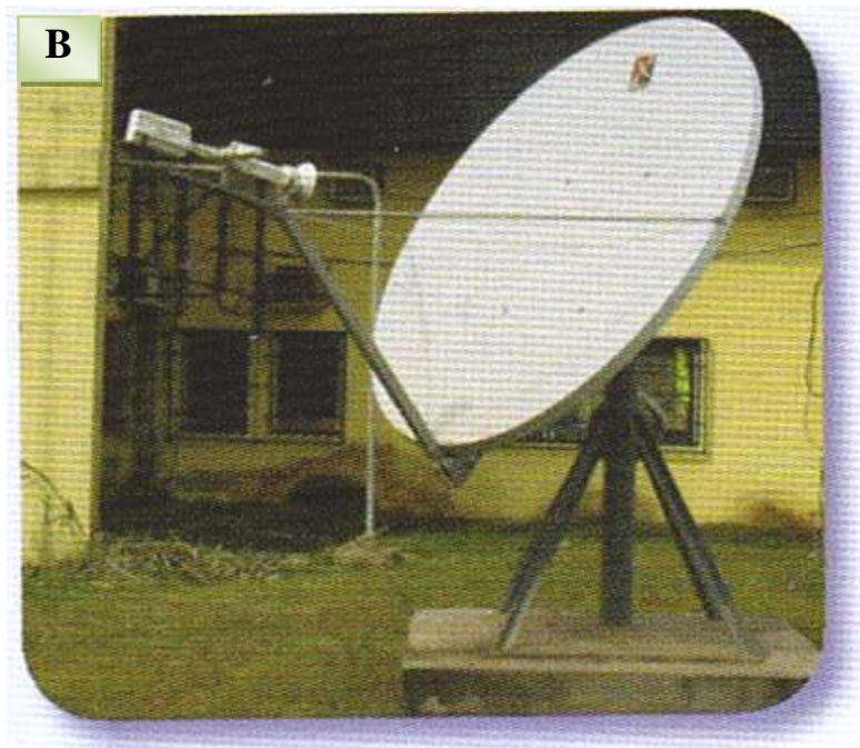
Exemple d'antenne VSAT implantée dans chaque gare du réseau SETRAG
