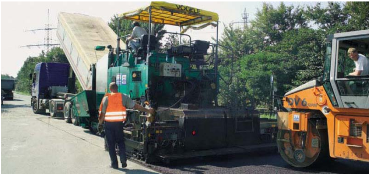
Figure I.4-6. Réalisation d'une couche d'accrochage avec un finisseur à rampe intégrée
