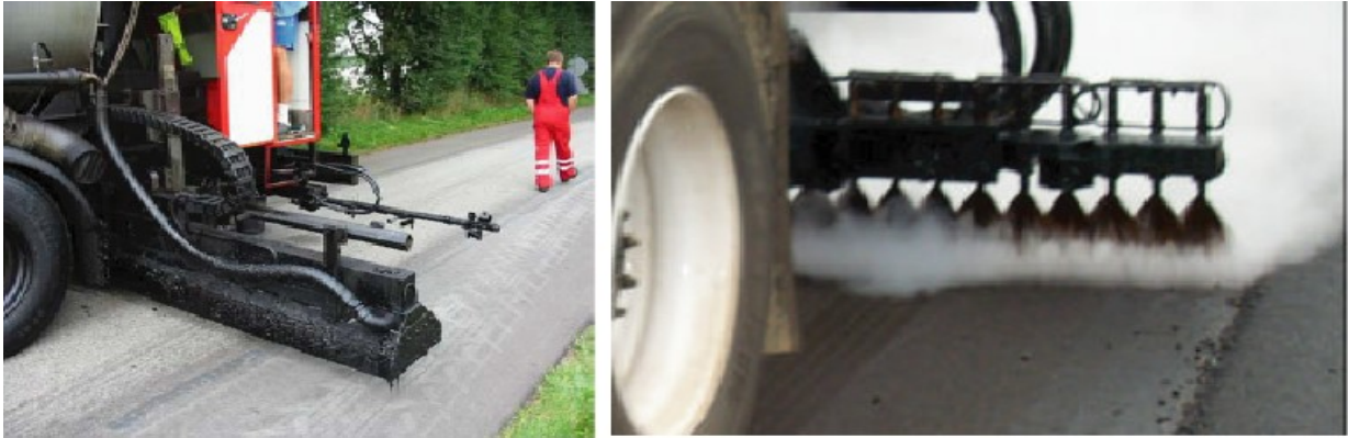
Figure I.4-5. Réalisation d'une couche d'accrochage avec un répandeur [RAS 02]
