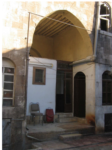
Photo 51 : Fermeture partielle de l'iwan pour l'aménagement d'une chambre (maison n° 35, Jdeideh, Alep, 2008)
