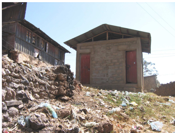
Photo 65 : Bloc de sanitaires collectifs (Compound Mohamed Ali, Harar, 2008)
