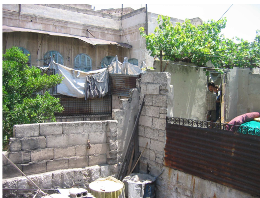
Photo 53 : Maison divisée en trois parties - 1 (maison n° 8, Bab el Hadid, Alep, 2008)
