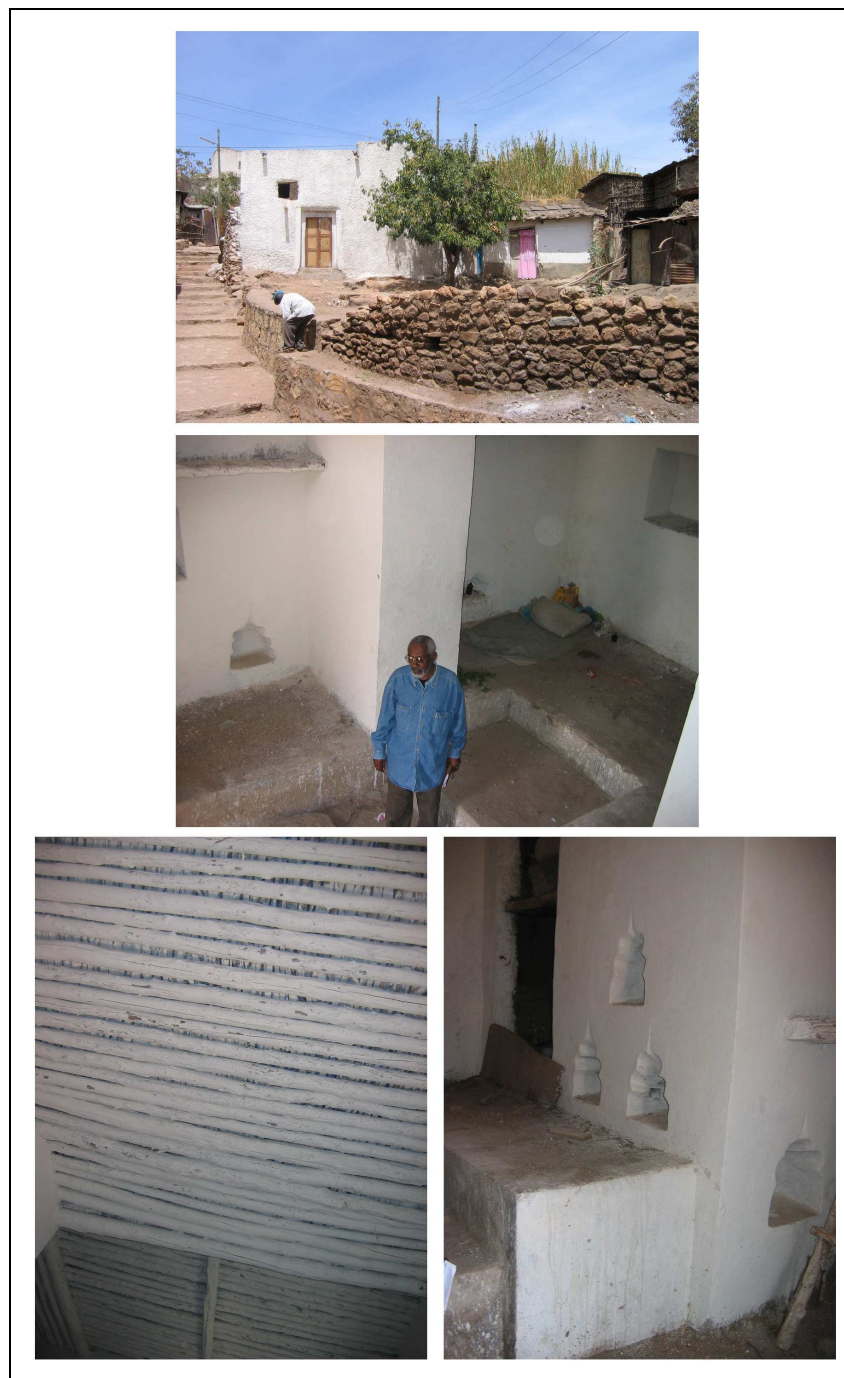
Photo 28 : La maison de qebele en cours de reconstruction à l'identique (Harar, 2008)
