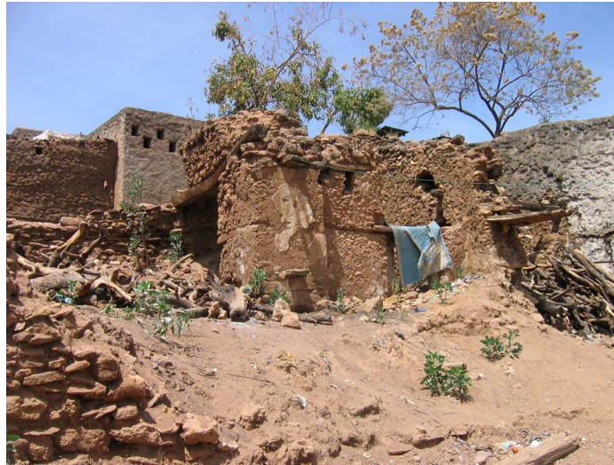
Photo 29 : Exemple de maison en ruines accolée au mur d'enceinte (SQ 05, Harar, 2008)
