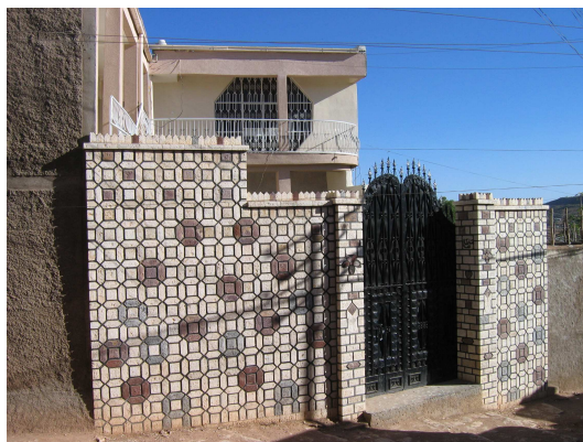
Photo 55 : Maison hararie du Jugol transformée avec des matériaux modernes (SQ 06, Harar, 2008)
