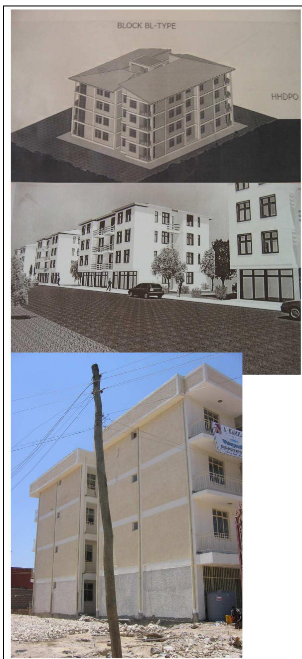
Figure 10 : Condominiums en projet à Harar et mise en œuvre
