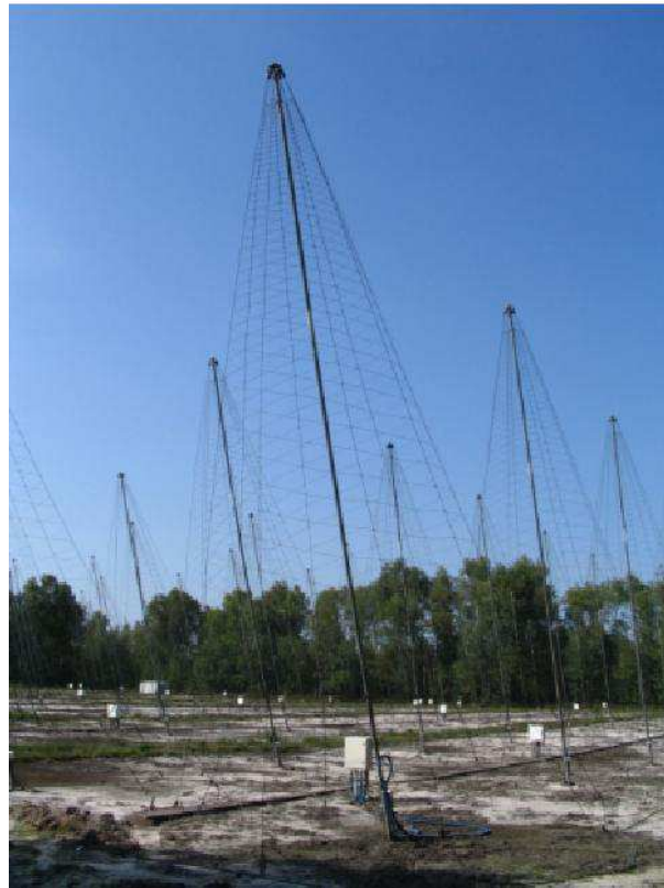
Fig. 2.8: Antennes log-périodiques du réseau décimétrique de Nançay, inclinées de 27^\circ au sud pour l'observation du Soleil.
