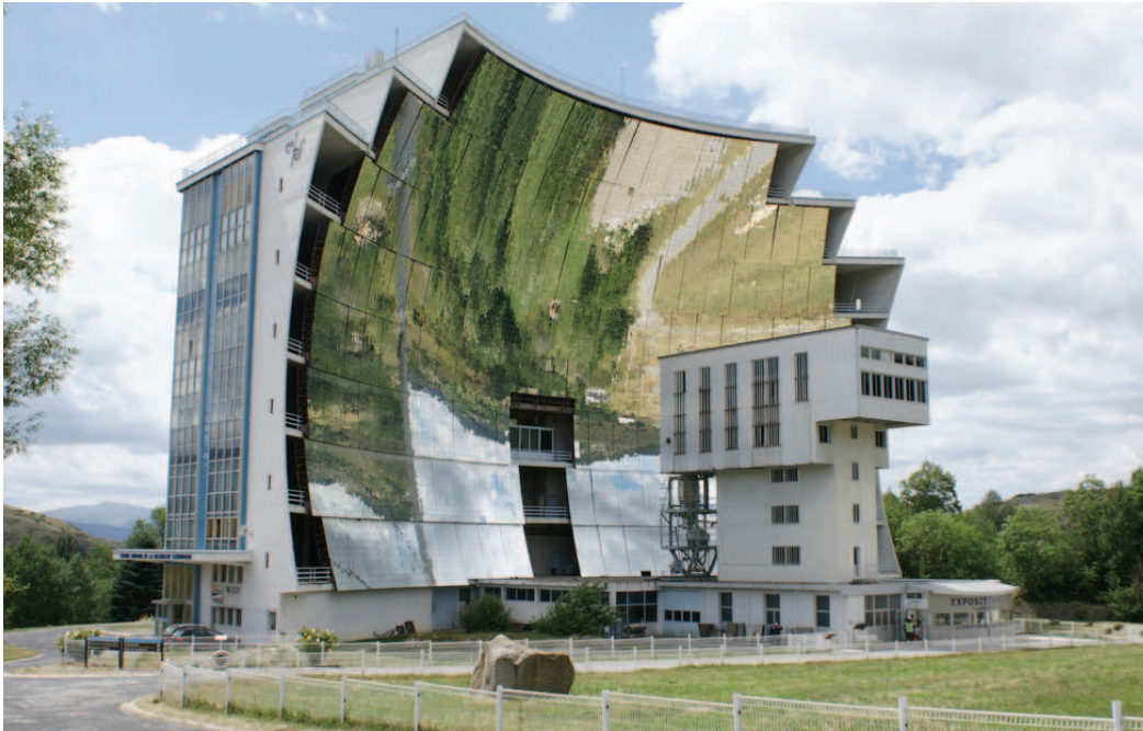
Figure 1–4 : Capteur solaire a concentration : four solaire d'Odeillo, puissance thermique 1\text{MW} , source PROMES [2010].
