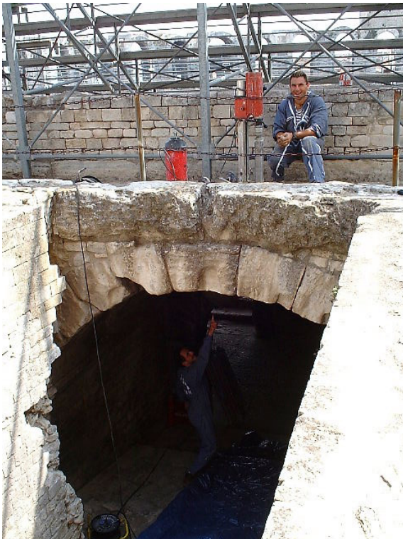
Fig.III.7. Carottage vertical au travers de la voûte de l'escalier d'accès au « promenoir » dans l'amphithéâtre d'Arles.
