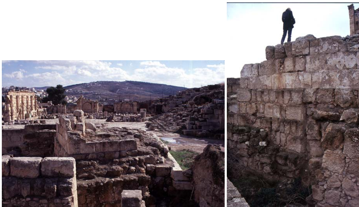
Fig.i7. Vues de l'autel du temple, depuis le nord (à gauche) et l'est (à droite ; face où l'on observe les vestiges de l'enduit).
