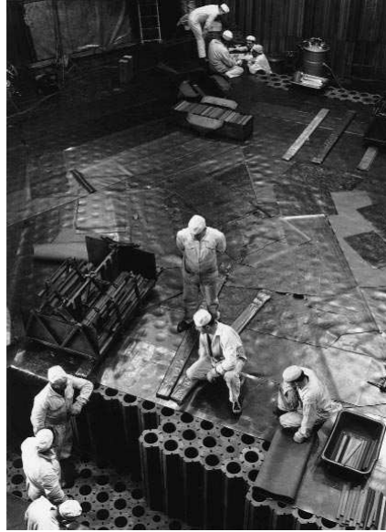
Figure 1-2 : Empilement de briques de graphite nucléaire pris en photographie lors de la construction du cœur de Chinon A3 en 1965 [Photothèque EDF]
