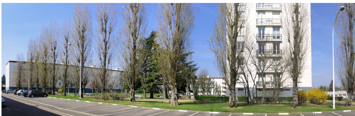
Figure 54. Le jardin en partie centrale de la résidence Gallardon, vu de puis l'intérieur de l'ensemble résidentiel (Réalisation personnelle, 2007).
