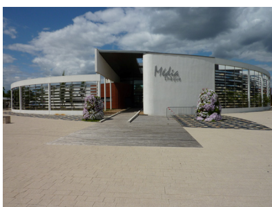
Figure 73. La médiathèque vue de la placette
