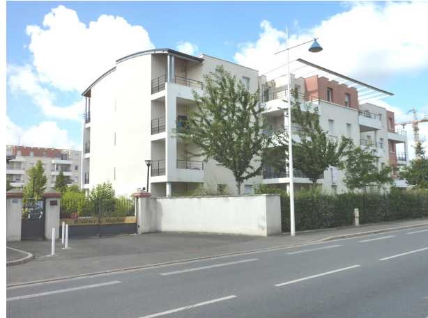
Figure 44. L'opération « Magellan » vue de l'avenue Edouard Michelin (Réalisation personnelle, 2010)
