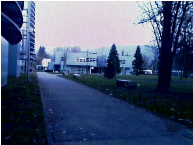
Figure 5.11 : vue de la cour de l'IMAG. L'environnement est plus complexe que dans le garage de l'INPG.
