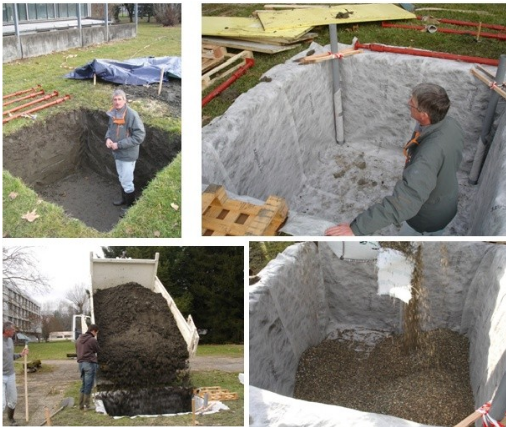
Figure 24 : Photo de la construction de la fosse : en haut à gauche, la fosse après terrassement, en haut à droite, drains verticaux et géotextile filtrant, en bas à droite gravier drainant placés sous la fosse, en bas à gauche, remplissage de la fosse par le sable limoneux
