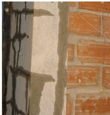
FIG. 3.9 – Écoulement d'eau dans le cadre du support dû à la conduction de chaleur du mur à travers la couche de mortier.
