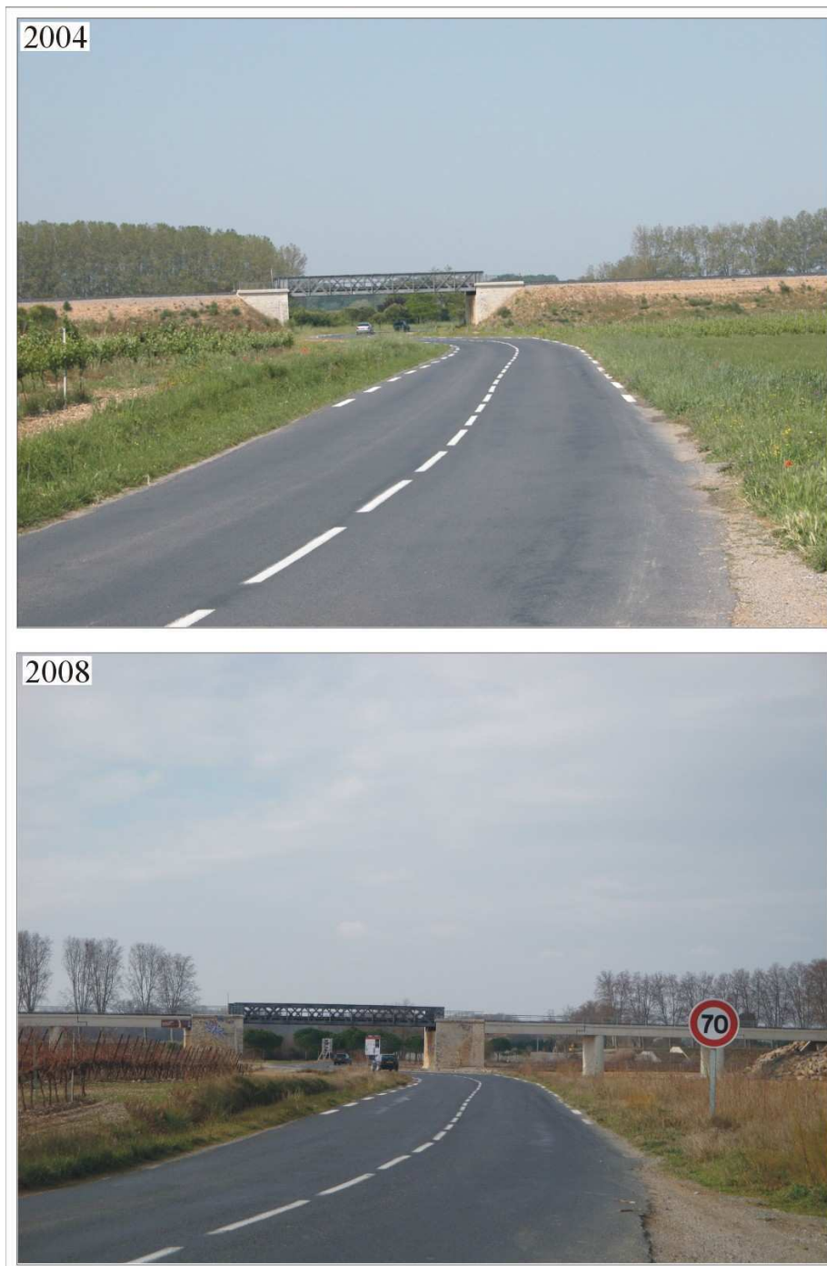
Photographie 5.3 : Remblai RFF avant (2004) et après (2008) travaux (Travaux de transparence hydraulique, Sallèles-d’Aude)
