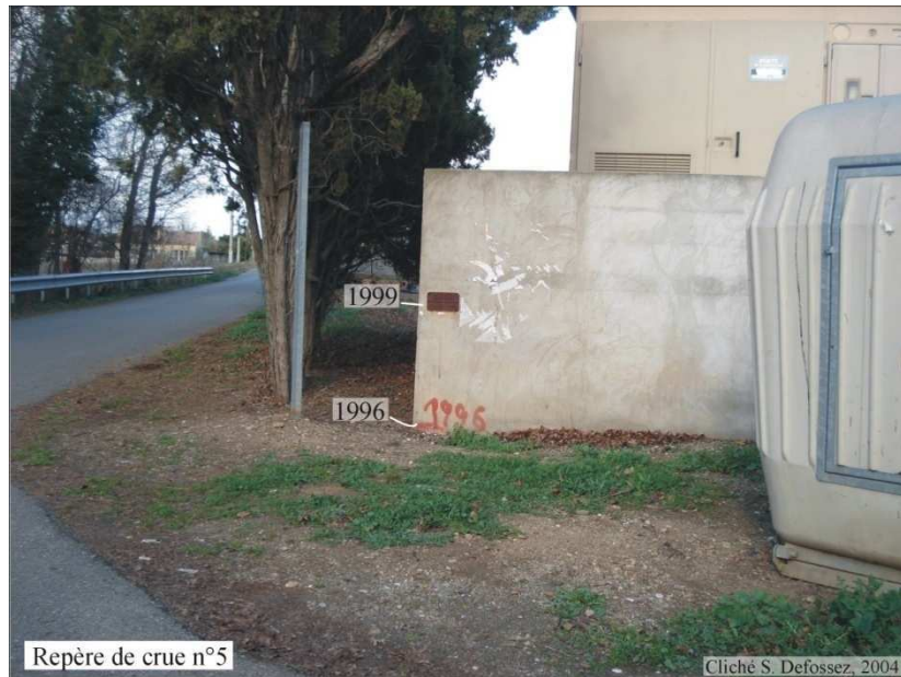
Photographie 7.7 : Repères de crue officiels de l'évènement de grande ampleur et officiels de l'évènement de moindre ampleur
