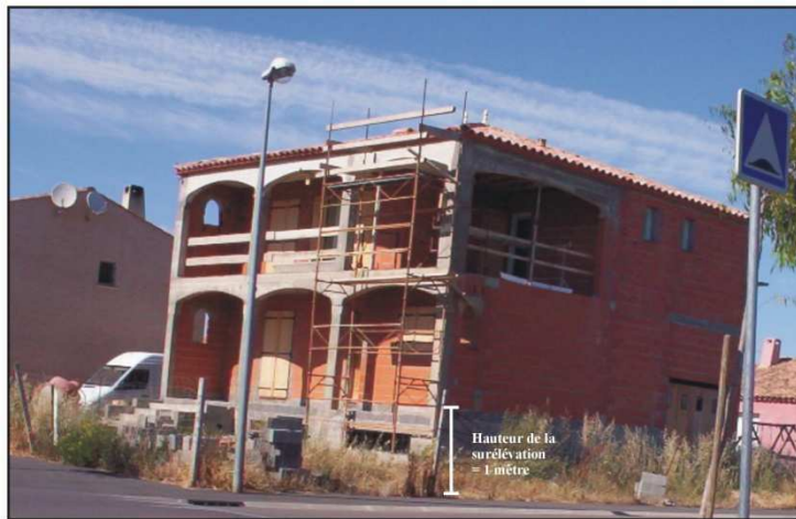
Habitation à étage au plancher surélevé. Coursan
