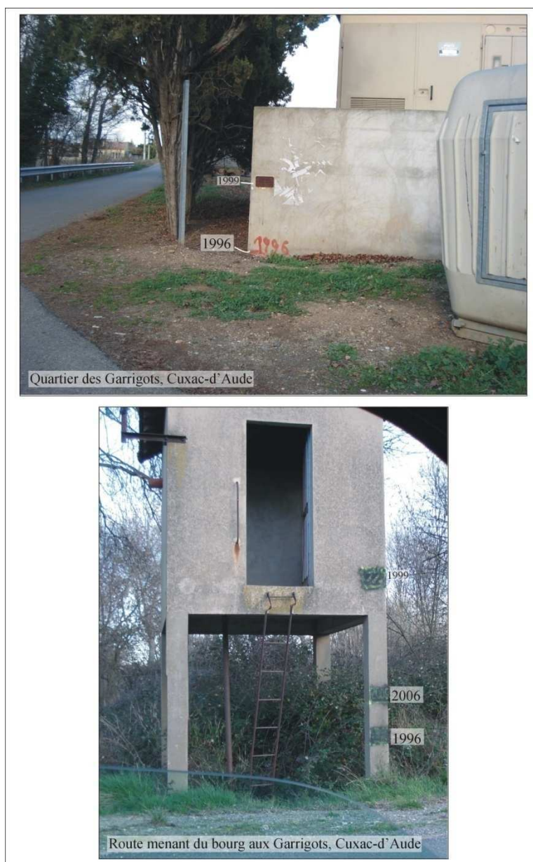
Photographie 6.5 : Hauteurs d'eau atteintes lors des évènements de moindre ampleur
