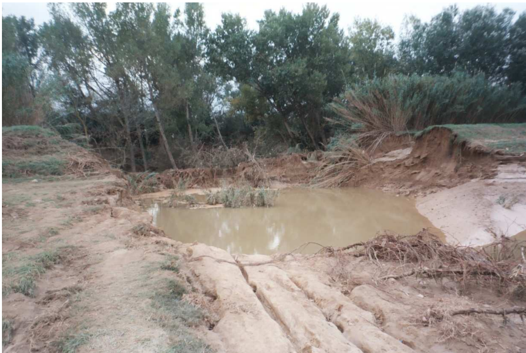
Photographie 5.4 : Brèche dans une digue à l'aval de Cuxac-d'Aude suite aux crues de novembre 2005 (Cliché : F Vinet, novembre 2005)
