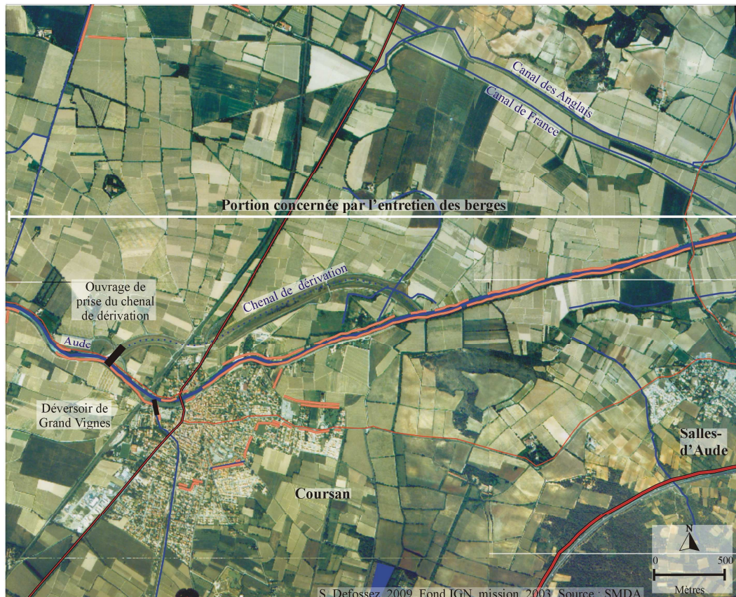
Figure 5.2 : Aménagements aux environs de Coursan
