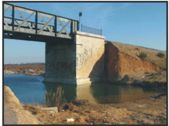
A : Remblai RFF fragilisé suite aux inondations de novembre 2005
