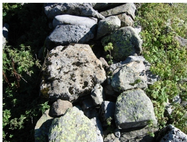
Détail du mur de la structure 21.
