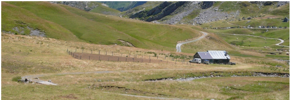
Fig. 186 : Vue de la cabane et de l'enclos de Houns de Gabès.
