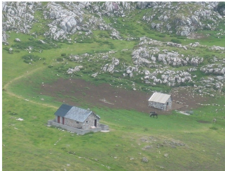
Fig. 27 : Vue de la cabane de la Cuarde.
