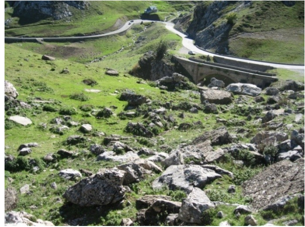
Vue de la structure 471.
