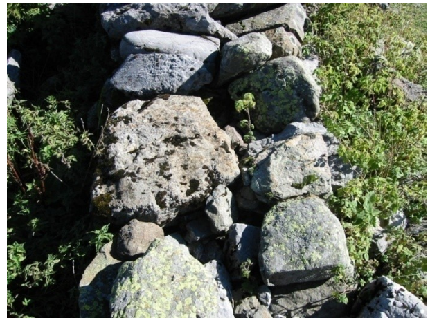
Détail du mur de la structure 21.
