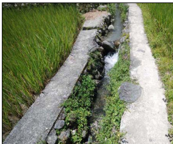
Photo 6.5. Canal d'irrigation cimenté et subventionné par le gouvernement à Hapao (Hungduan, avril 2008).
