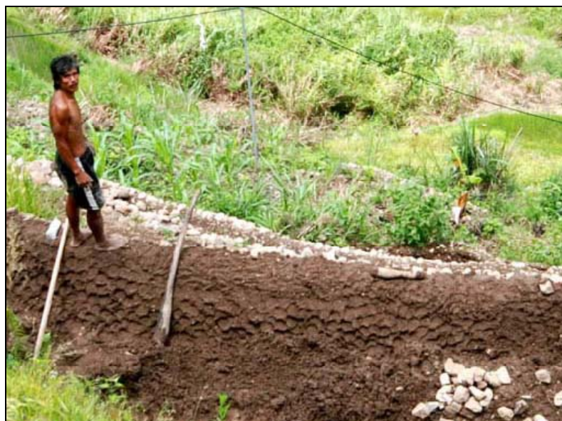
Photo 6.3. Homme réparant une terrasse à Batad (Banaue, juin 2008). À l'aide d'un pilon en bois, le bâtisseur tasse l'argile pour augmenter la cohésion entre les pierres du mur.
