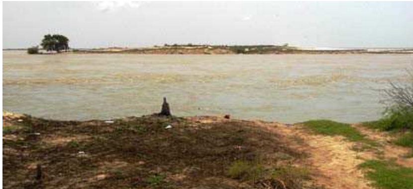
FIG. B.3: La brèche le 24 novembre.
