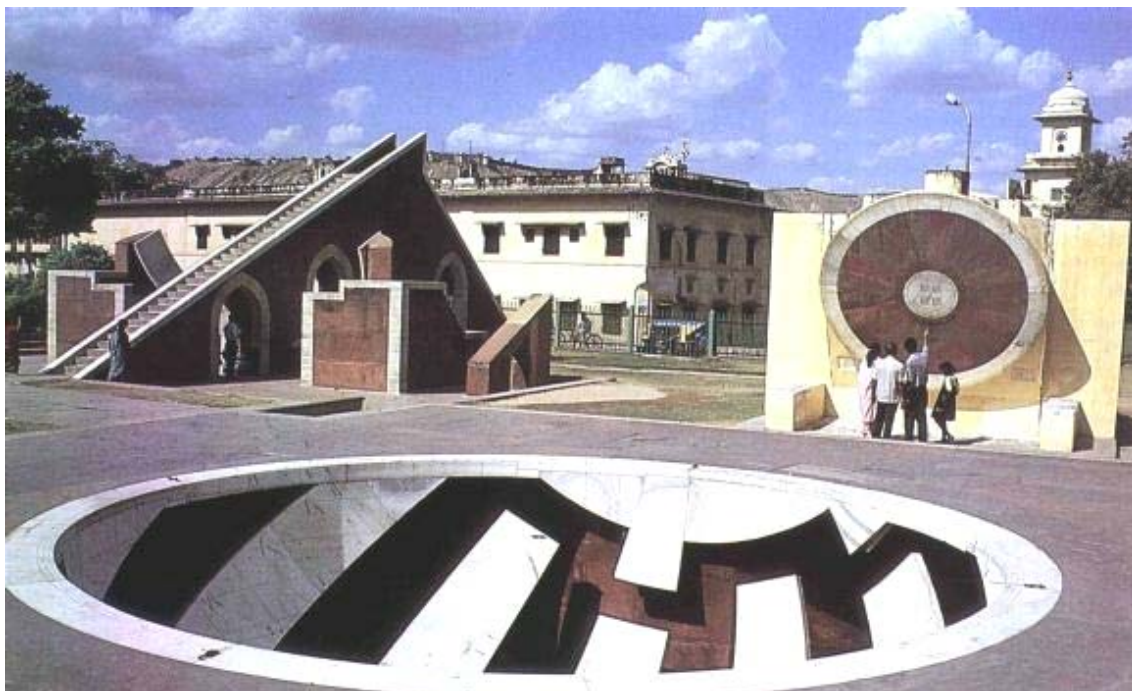
Fig. 52. Trois éléments du Jantar Mantar de Jaipur : a) A l'arrière plan le « petit » cadran, au gnomon Incliné de 27^\circ sur l'horizontale (latitude de Jaipur) ; b) à l'arrière plan également, un cadran solaire équatorial circulaire (la lecture s'effectue sur deux faces parallèles, la face nord étant utilisable entre le 21 mars et le 21 sept., la face sud les six autres mois ; la lecture est donc rendue difficile aux périodes d'équinoxes) ; c) au premier plan, l'impressionnant Jai Prakash Yantra , composé de deux hémisphères inversés complémentaires (un seul est photographié ici), qui permet la lecture de la position solaire grâce à l'ombre portée d'un anneau fixe situé au centre de l'hémisphère ; le repérage nocturne est également possible pour un observateur situé sous les « lés » de marbre et visant les astres au travers de l'anneau.
