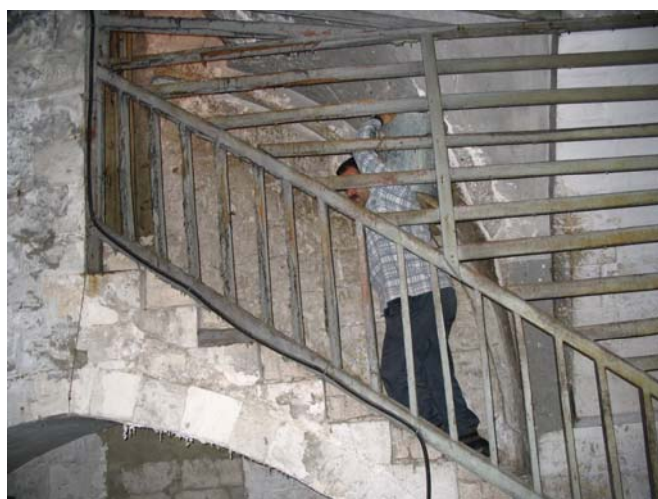
Photo 40. Les ouvriers du bast montent à l'étage...
