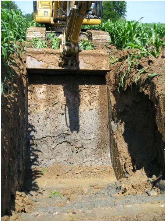
Fig. 5.12 : Niveau hydromorphe mis au jour par le diagnostic de la LGV Est, Duntzenheim, 67.
