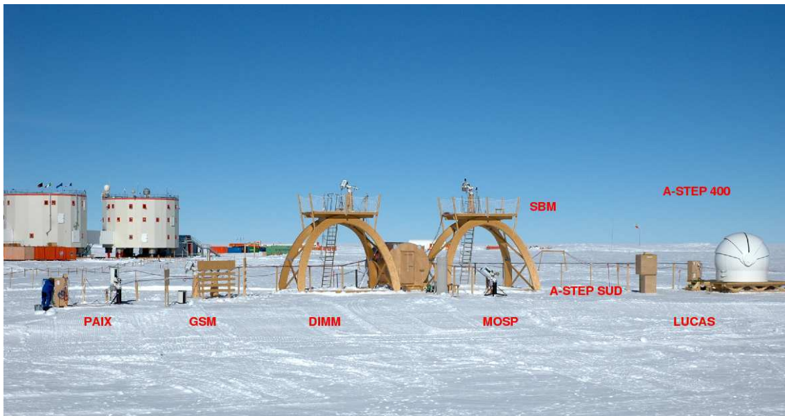
FIGURE 1.12 – La station Concordia et la plateforme Astroconcordia, espace dédié aux instruments d'astronomie. Les instruments sont soit au niveau du sol, soit sur une structure en bois de 8 m de haut. Un abri en bois relié à la station contient les ordinateurs et les appareils permettant de faire fonctionner les instruments.
