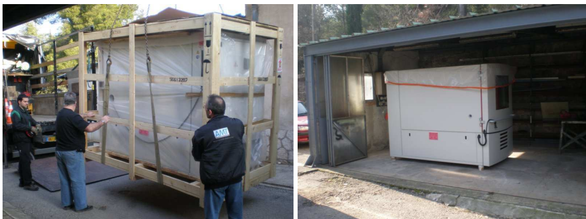
FIGURE 7.31 – Installation de l’enceinte thermique au Mont Gros à Nice. Cette enceinte permet de tester les éléments du télescope sous les températures du Dôme C.
