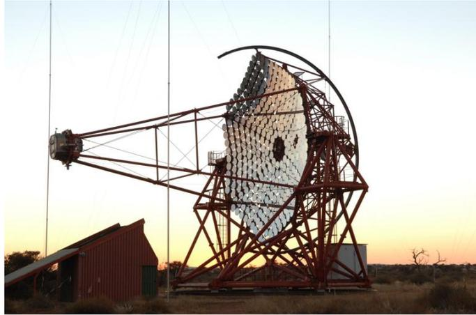
FIGURE 4.11 – Photographie d'un télescope de l'expérience H.E.S.S. La surface réfléchissante est composée de 380 facettes circulaires de 60 cm de diamètre, couvrant une surface de 107 m<sup>2</sup>. Les photons issus du rayonnement Cherenkov sont focalisés sur la caméra, placée à 15 m du miroir (Crédit : Claude Delhayé - Photothèque CNRS).
