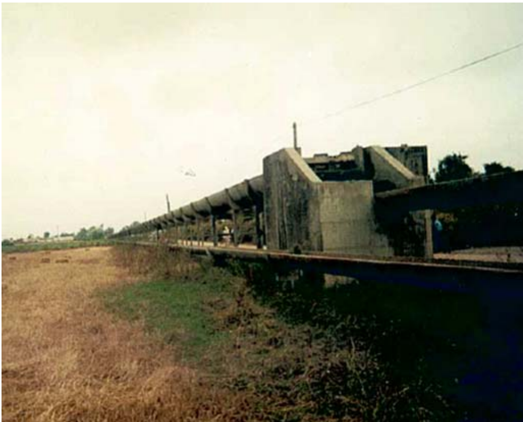
Figure 2- 25 – Transport de l'eau par canal en béton surélevé et de section hémicylindrique dans le Gharb (longueur : environ 1000 m).
