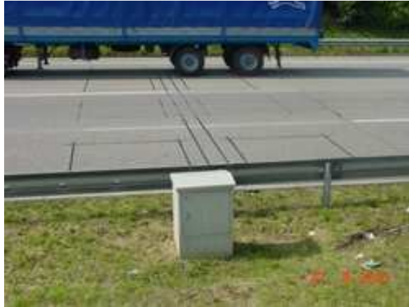
Figure 1.3 – Photo de boucles électromagnétiques (réseau OFROU, suisse).
