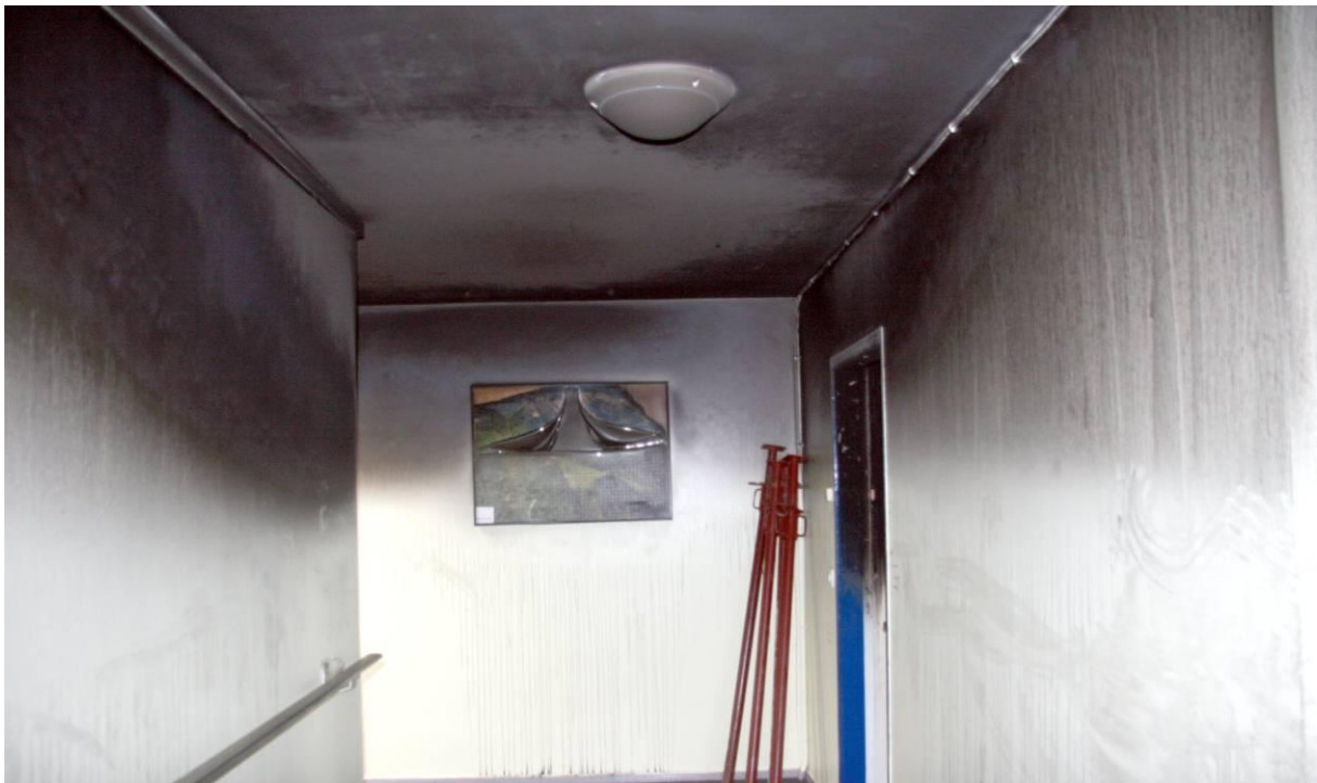
302. Vue de l'entrée de l'appartement depuis la circulation commune
