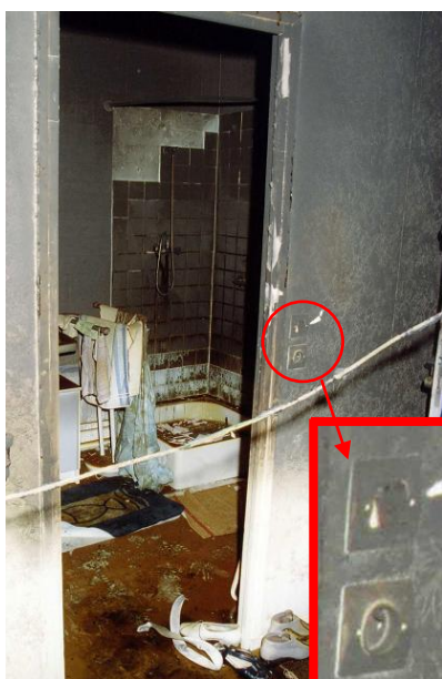
329. Prise de courant et interrupteur dans la pièce principale de l'appartement sinistré à la sortie de la salle de bain
