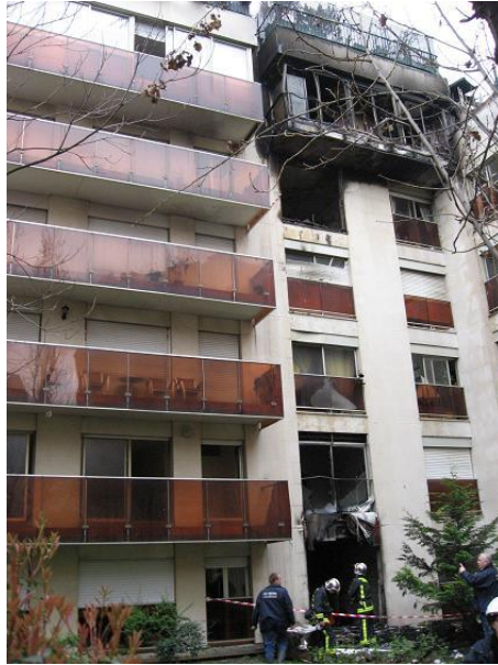
188. Vue extérieure depuis une cour intérieure d'une façade du bâtiment sinistré
