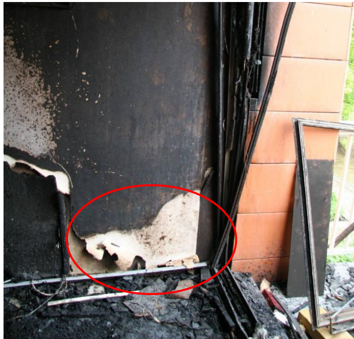
352. Mur entre le lit et la paroi extérieure
