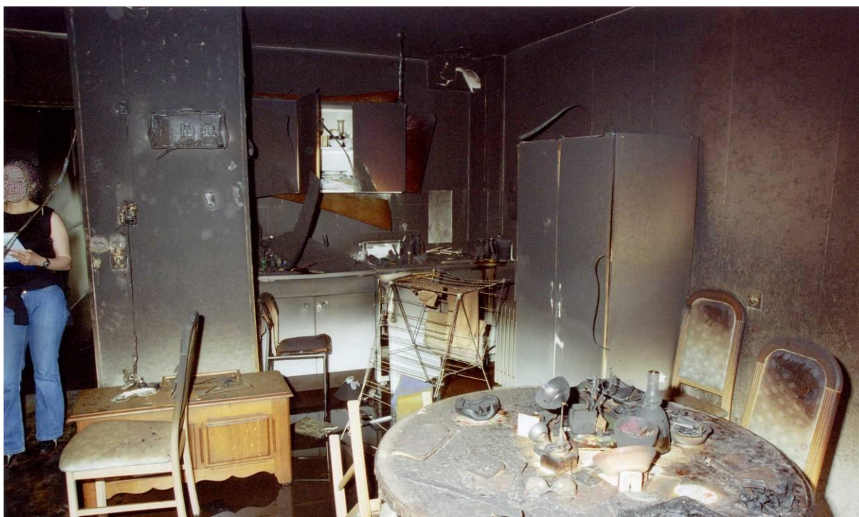
297. Vue d'ensemble de la cuisine de l'appartement sinistré
