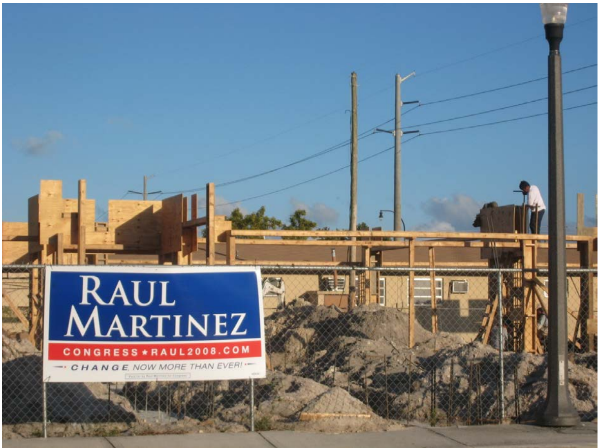
Photo 10 : Chantier à Hialeah en période de campagne électorale...
