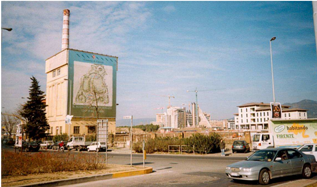
Photo 14.8 : L'aire F.I.A.T., avec au fond le nouveau Palais de Justice en construction (fév. 2005)
