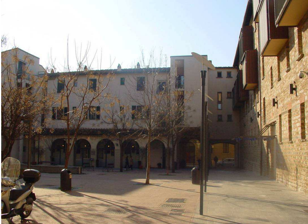
Photos 14.5 : Réhabilitation des Murate en logements sociaux (fév. 2010)
