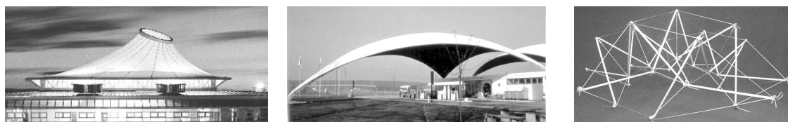
Fig. IV.6 : Membrane précontrainte, coque funiculaire (H. Isler) et système de tensegrité autocontraint (LMGC)
