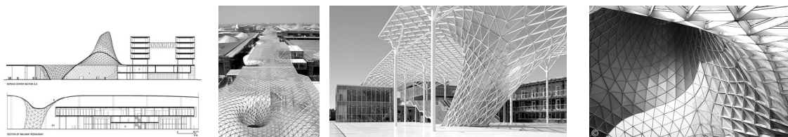
Fig. IV.3 : Couverture de la foire de Milan (ossature métallique et panneaux de verre)
