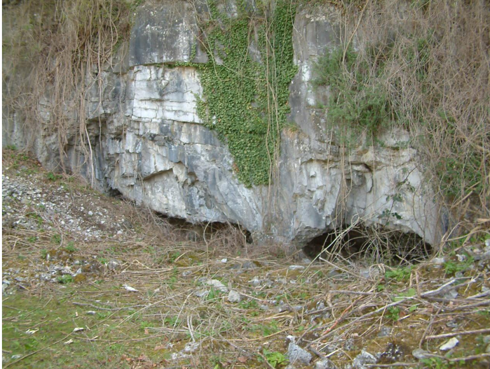
Figure 132 : la cavité dans son état actuel, avec ses deux entrées séparées par un pilier et quasi-totalement colmatée par des remblais (cliché K. Di Modica)
