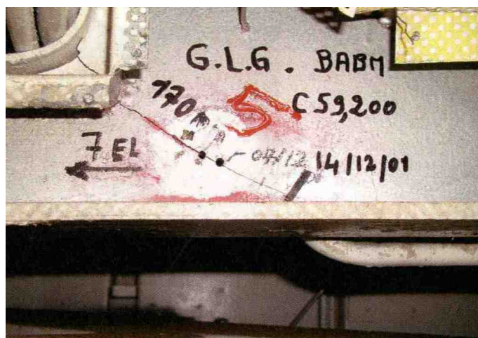
FIGURE 1.2: Exemple de fissure ayant été amorcée dans un cordon de soudure. (Source : DGA Bagneux)
