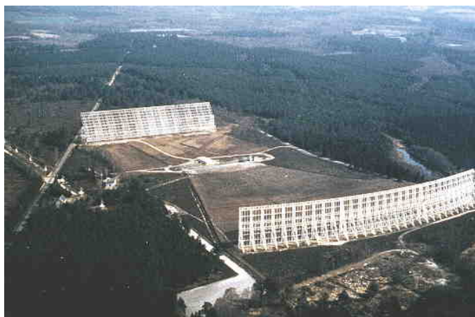
FIGURE 2.3 – Le radiotélescope constitué d'un miroir plan dont le rôle est de renvoyer les ondes captées vers le miroir sphérique qui les renvoie à son tour vers le chariot focal au centre de l'image. Les différents miroirs sont composés d'un grillage métallique dont le maillage de 12.4 mm agit comme un miroir parfait pour les longueurs d'ondes observées.
