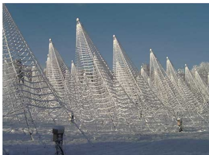
FIGURE 2.5 – Le réseau décimétrique de Nançay couvert de neige. Les brins formant les antennes sont clairement visibles. Afin de pointer dans la direction moyenne du Soleil et de Jupiter au cours de l'année, les antennes sont inclinées de 20 degrés vers le Sud.
