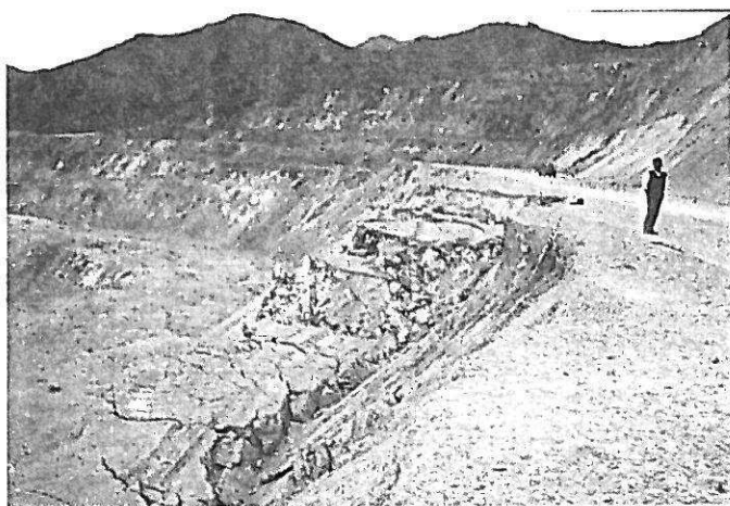
Figure 17 - Rupture en dièdres emboîtés d'un gradin. Mine de Sar Cheshmeh, NICICO, Iran.
