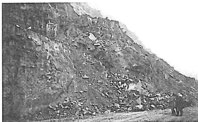
Figure 21 - Flanc ouest de la découverte de Decazeville, HBCM. Vue du glissement.
