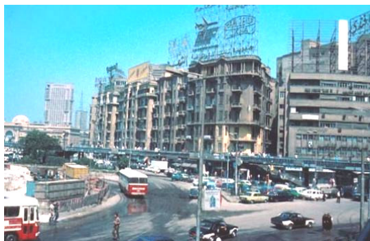
(Fig. 1.12) Les travaux du métro Place de Tahrir, on voit la passerelle des piétons qui traverse la place et qui fut démolie à la fin du chantier.
