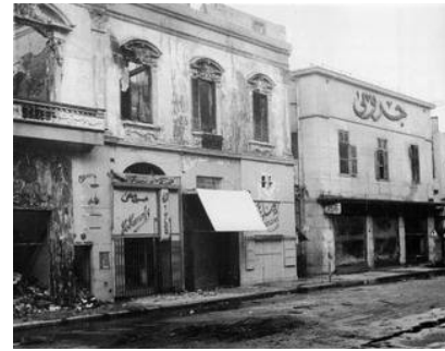
(Fig. 1.42) Le Club Khédivial rue Maghrabi et le salon de thé Groppi. Les deux bâtiments furent complètement ruinés par l'incendie du Caire. www.egyptedantan.com/egypt.htm
