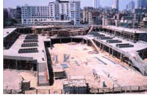
(Fig. 1.94) Les travaux dans la zone de Mawardy après la démolition. Source : Le portail électronique du Caire
