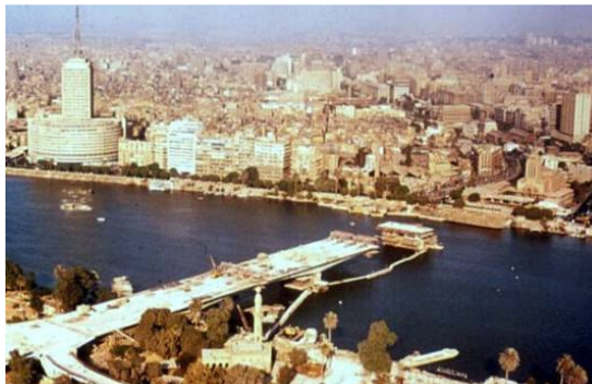
(Fig. 1.13) Les travaux du pont Six Octobre.
