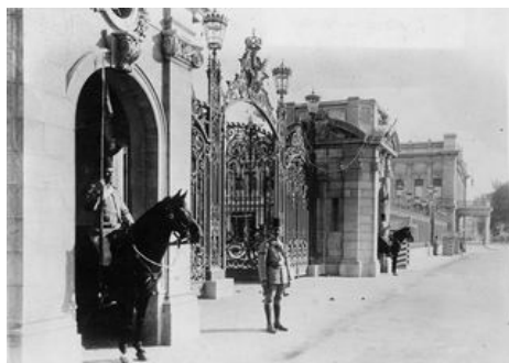
(Fig. 1.30) Palais Royal d'Abdîn. Entrée principale, vers 1931
