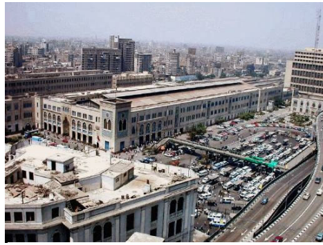
(Fig. 1.73) L'ancienne station de microbus devant la gare avant son déplacement Source : El Masry El Yom
