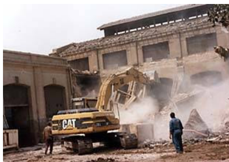
(Fig. 1.98) La démolition de l'abattoir en 1998
