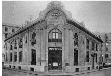
(Fig. 1.34) Rue El Borsa el Guedida, Guerre de 1914-1918, l'ancienne Bourse du Caire transformée en "Anzac Hôtel" du YMCA. Cliché de 1916.
