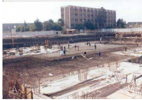
(Fig. 1.100) Le début des travaux de l'hôpital en 2001
