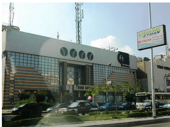
(Fig. 2.54) Tiba Mall à Nasr City, un de premiers Malls construits aux années 1990.
