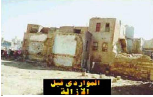
(Fig. 1.93) El Mawardy à Sayéda Zeinab avant la démolition de la zone informelle. Source : Le portail électronique du Caire
