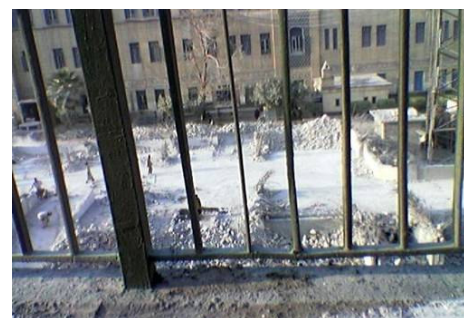
(Fig. 1.72) le site après la démolition du parking Source : El Gomhouriya
