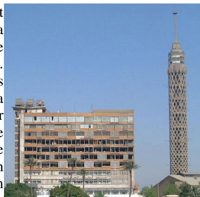
(Fig. 1.53) La Tour du Caire et à gauche de la photo, l'hôtel de la tour (El-Bourg) construit dans les années 1960 avec des façades laides qui reflètent l'orientation socialiste de l'époque, cet hôtel est encore en mauvais état aujourd'hui. Source : Samir Raafat
