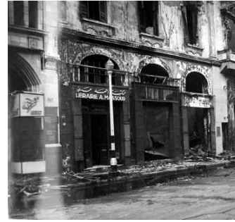
(Fig. 1.45) Même les biens des Egyptiens ne furent pas épargnés par l'incendie : la fameuse Librairie d'Ahmed Massoud entièrement détruite. Source : Misr El-Mahroussa
