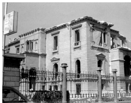
(Fig. 1.60) La démolition du palais Source : Samir Raafat, Cairo Times
