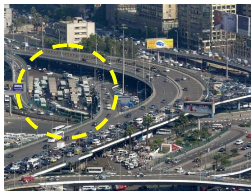
(Fig. 3.20) Le terminus de bus, situé sous le pont de 6 Octobre sur la place Abdel Moneim Riyadh
