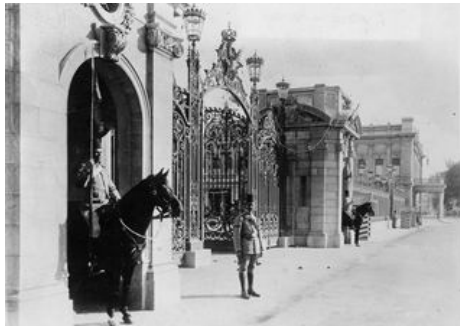
(Fig. 1.30) Palais Royal d'Abdîn. Entrée principale, vers 1931
