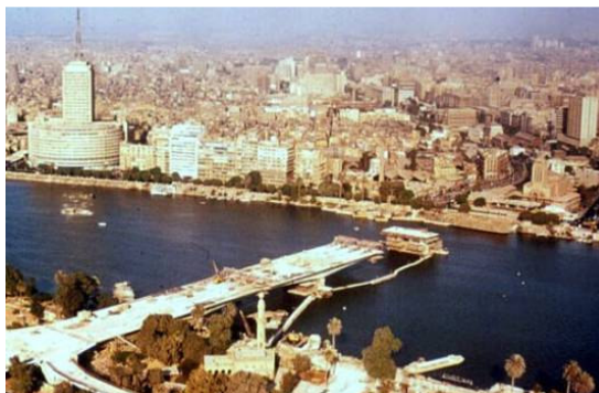
(Fig. 1.13) Les travaux du pont Six Octobre.
