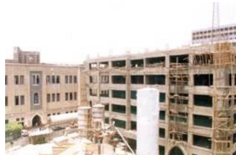
(Fig. 1.71) La structure béton du parking Source : El Gomhouriya
