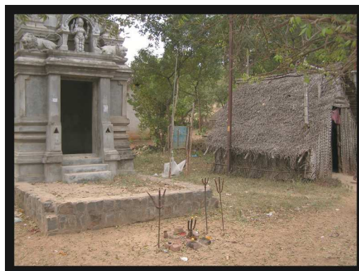
Temples de la Kāliammaṅ. Celui au toit de chaume est l'ancien, celui de gauche est en cours de rénovation.
