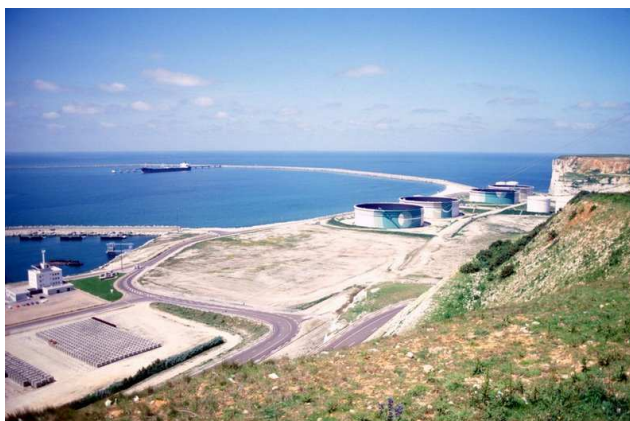
Photo 35 : Actuel terminal méthanier. En arrière-plan, un pétrolier décharge sa cargaison sur l'un des appontements de la digue nord, à droite les cuves de stockage. Source : AREHN.
