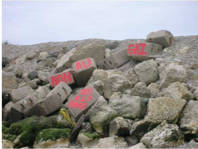
Photo 38 : Illustration de l'opposition au projet, les graffiti réalisés sur la digue sud du port pétrolier, de nombreux écriteaux sont également visibles dans la commune.
