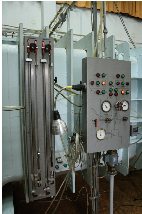
Figure 5.3. Photo des colonnes de mercure de mesure de pression d'entrée de veine et de pression différentielle amont / aval convergent, et des vannes de régulation manuelle
