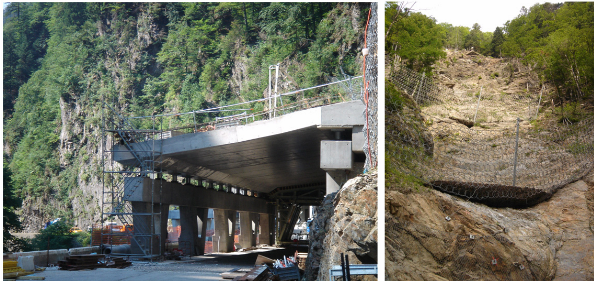
Figure V.7 : ouvrage de la Poniente et couloir à risque
